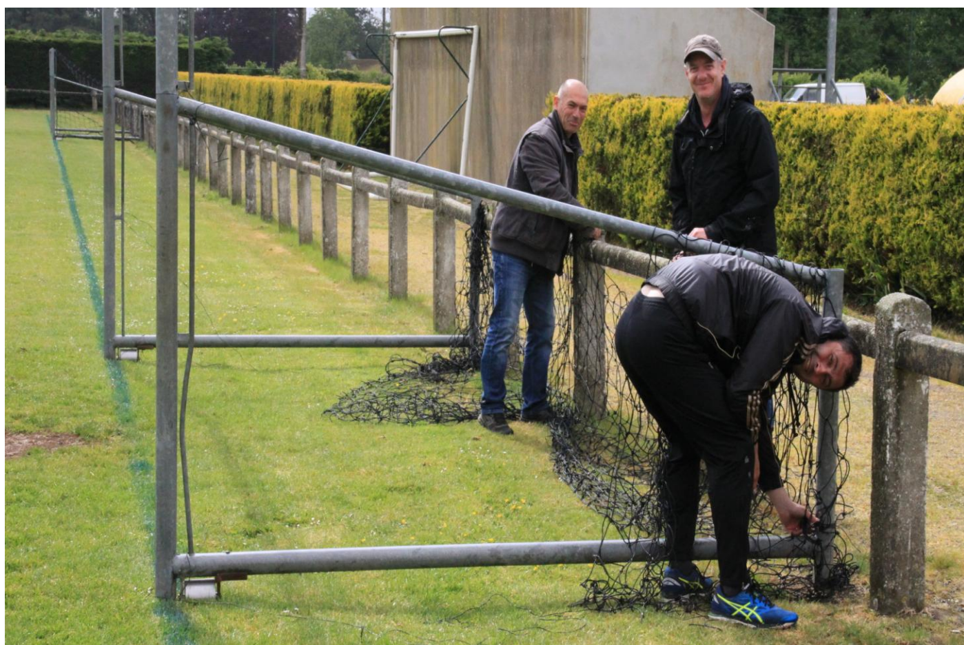
TROIS BENEVOLES A L'OUVRAGE POUR ENLEVER LES FILETS ET TOUT REMETTRE EN ETAT POUR LE DIMANCHE...
