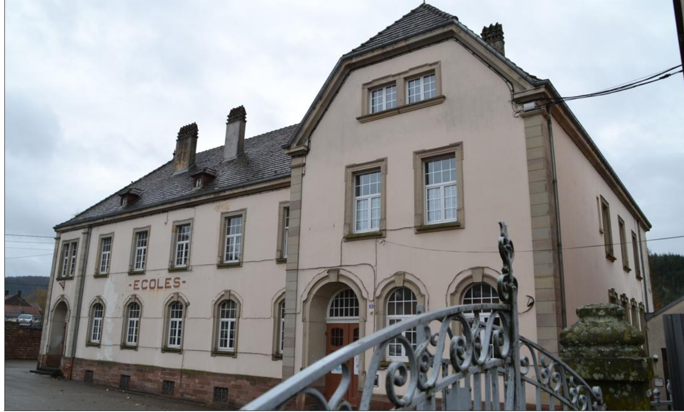
La Maison de santé, qui devrait s'installer dans les locaux de l'ancienne école, reste le projet phare de la commune. Photo RL
