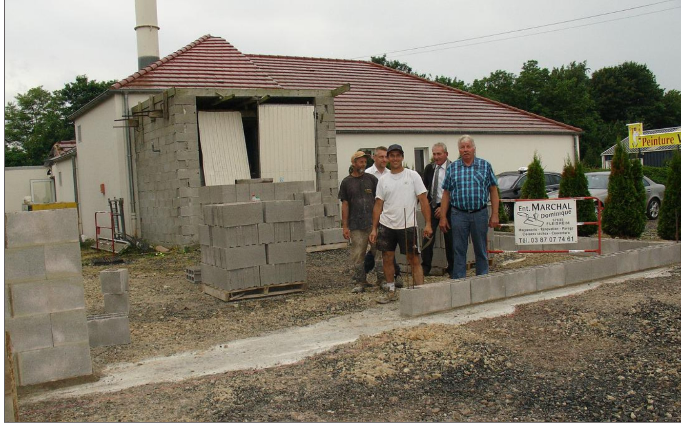
Le deuxième four devrait être opérationnel à la fin de l'année. Le bâtiment sera aux normes exigées par l'ARS. Photo RL
