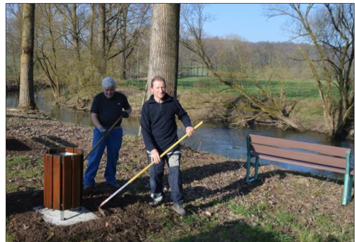
Gilbert Gassmann et Antoine De Maio ont soigneusement réalisé les travaux. Photo RL.
