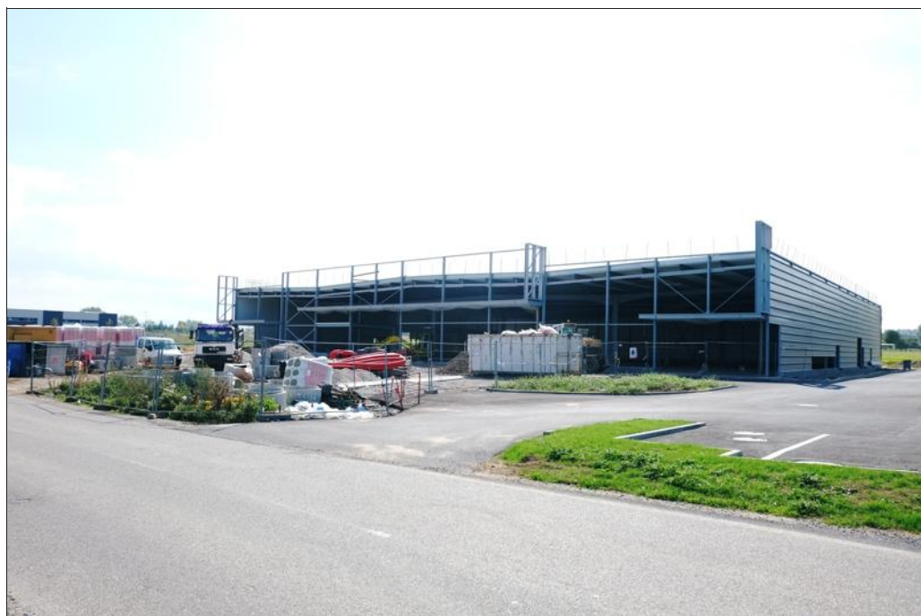
Les extensions ou créations de zones d'activités, comme dans le quartier Est de Sarrebourg, sont des chantiers importants pour le secteur du BTP. Mais ils se font rares. Photo Laurent CLAUDE
