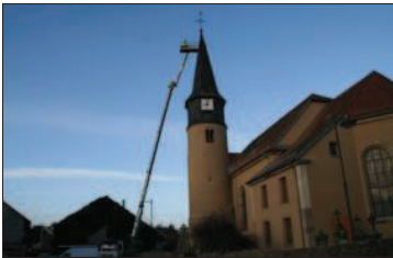
Le paratonnerre objet de travaux de remise en état a aussi suscité la curiosité des villageois surpris par l'imposante nacelle.
