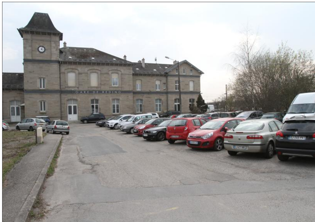
Le réaménagement du parking de la gare de Réding fait partie des investissements programmés par la communauté de communes Sarrebourg Moselle sud. Photo Laurent MAMI
