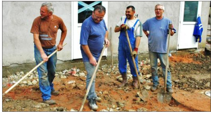
Quatre administrateurs du comité font de la musculation au Club House. Le coulage des fondations est imminent. Photo RL
