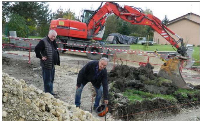
Le maire Alain Pierson et l'adjoint aux travaux Noël Tonegutti font un point sur l'avancée du chantier. Photo RL
